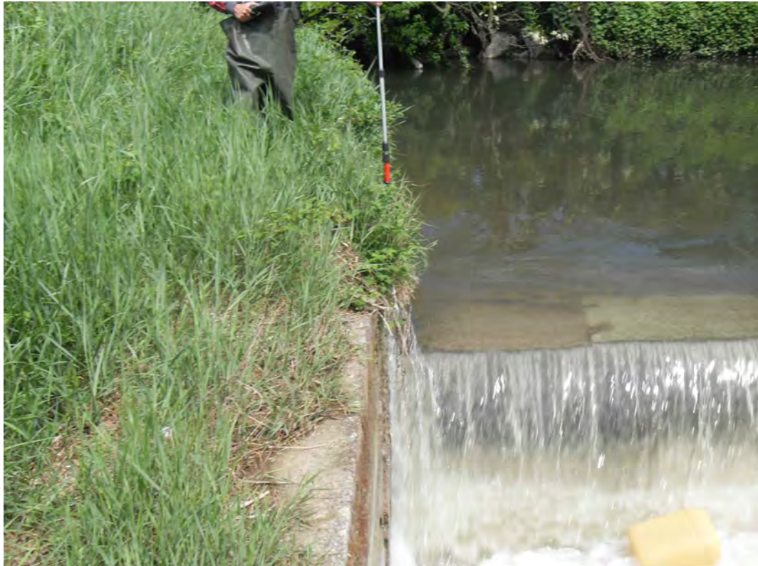
Dettaglio del rivestimento del ciglio sfiorante in elementi lapidei
